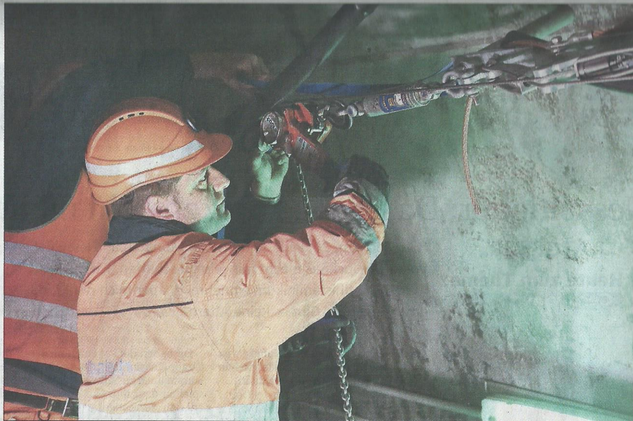
Mitarbeiter der Firma Elbatech spannen das Tunnelfunk-Kabel im Gotthard-Basistunnel.
